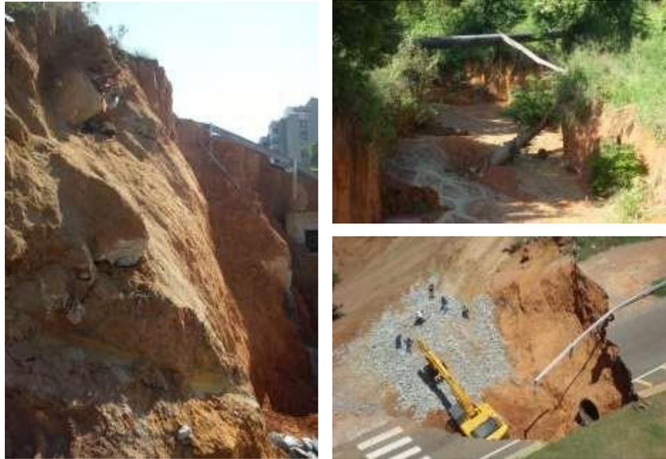
Figura 16. Colapso de taludes e infraestructura ocurrido después de 6 horas de lluvia, septiembre de 2008
