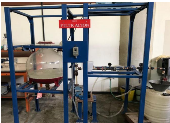
Figura 2. Equipos correspondientes al proceso de filtración disponibles en el laboratorio de la Universidad Metropolitana.
