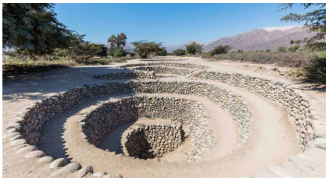
Figura 12. Detalle de un puquio, limitado por muros helicoidales construidos con cantos redondeados.
