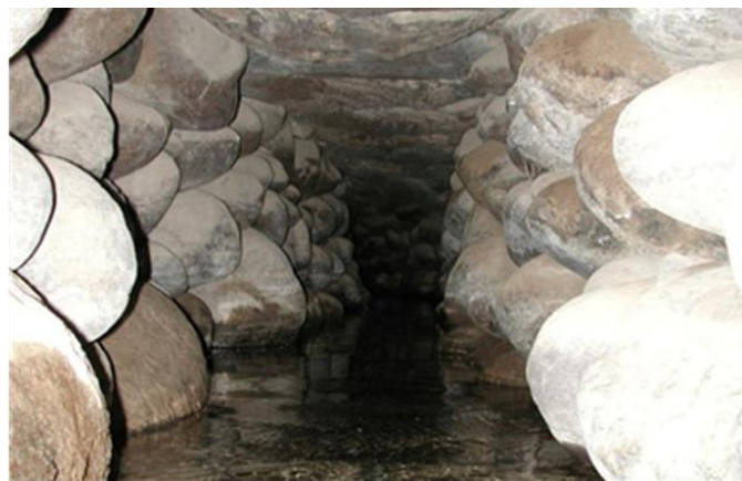
Figura 14. Detalle de conducción subterránea con cantos redondeados y techo con rocas de bordes planos.
