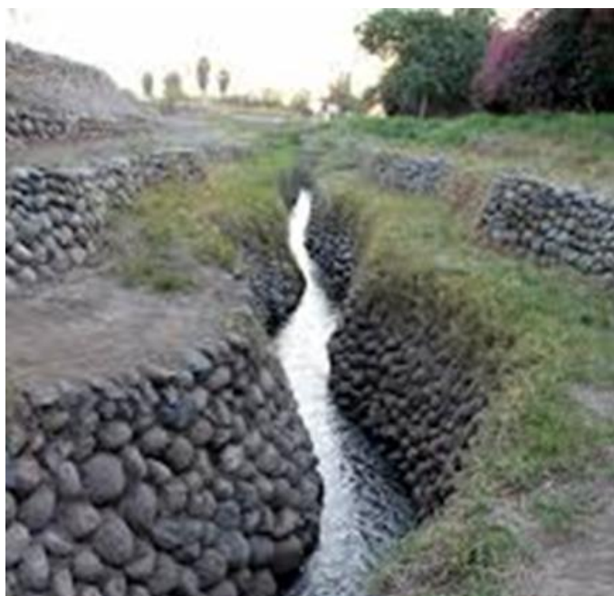
Figura 13. Detalle de canal con paredes de bloques de roca redondeados y ligeramente cementados.
