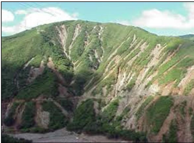
Figura 4: Vista de los numerosos surcos de drenaje en la ladera, hacia cauce secundario de gran pendiente. Efectos del Deslave de Vargas 1999, Venezuela
