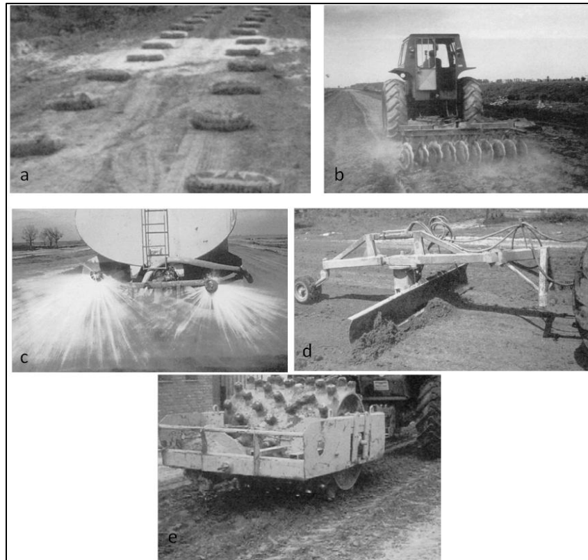
Figura 5: Pasos para construcción de pavimentos con suelo cemento; a) distribución del cemento en sacos en la vía de acuerdo con la concentración a utilizar según el tipo de suelo, b) escarificación del suelo y mezcla con el cemento en seco, c) incorporación del agua de acuerdo con la relación A/C deseada y el tipo de suelo, d) nivelación del material humedecido y e) compactación del suelo cemento durante el fraguado para reducir los espacios vacíos y permitir la mejor distribución del agente cementante en la mezcla. Fuente: Imágenes de compactación del suelo, [3]
