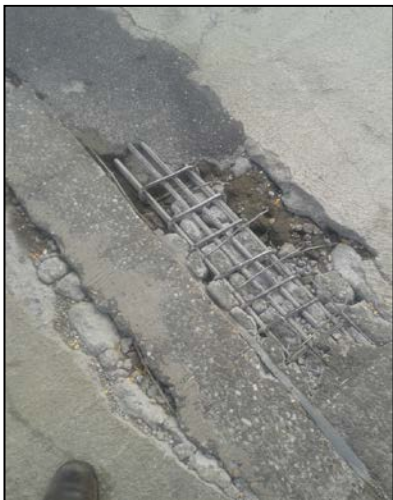
Figura 23: Patrón de Agrietamiento en juntas de dilatación de tableros mixtos (13 m). Fuente: Elaboración propia
