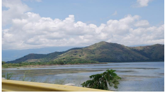
Figura 6: Presencia de Depósitos de Sedimento en el Embalse Aguas Abajo de la Carretera Nirgua-Chivacoa (2017)
