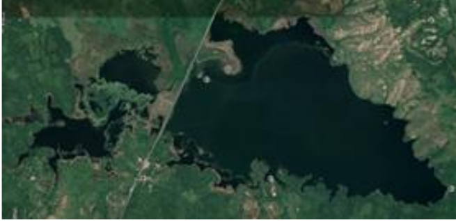
Figura 9: Avance de los Depósitos de Sedimento en Ambos Lados de la Carretera Nirgua-Chivacoa (2018)
