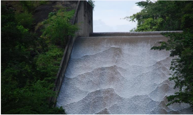
Figura 4: Aliviadero del Embalse Cumaripa (2017)
