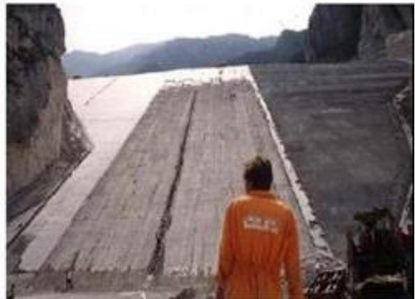
Figura 17: Presa Bovilla, Albania. Geo membrana como elemento impermeable de una presa de grava
