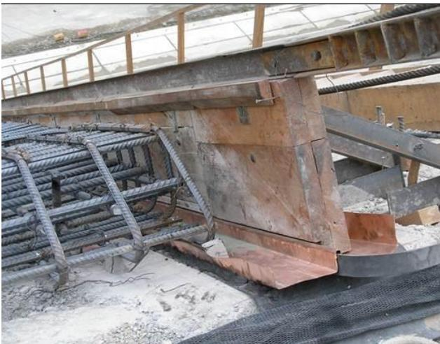
Figura 15: Presa Limón/Olmos. Detalle de junta vertical [11]
