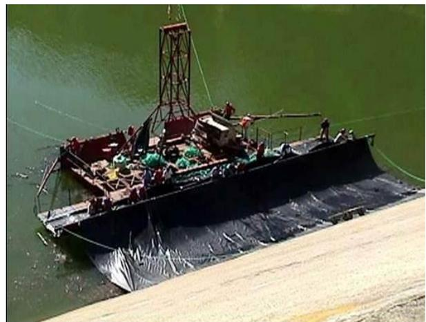
Figura 16: Presa Turimiquire. Colocación de membrana (cortesía Ing. C. Pimentel)
