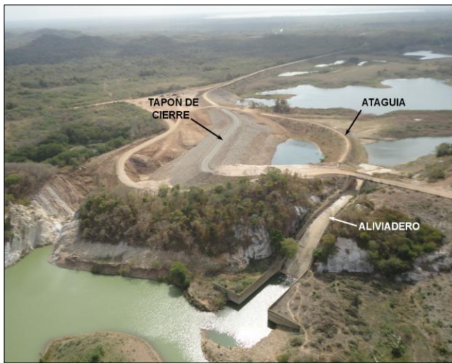
Figura 22: Dique de Cierre de la Brecha Terminado
