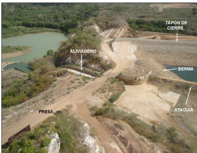
Figura 23: Dique de Cierre de la Brecha y Berma Sobre el Estribo
