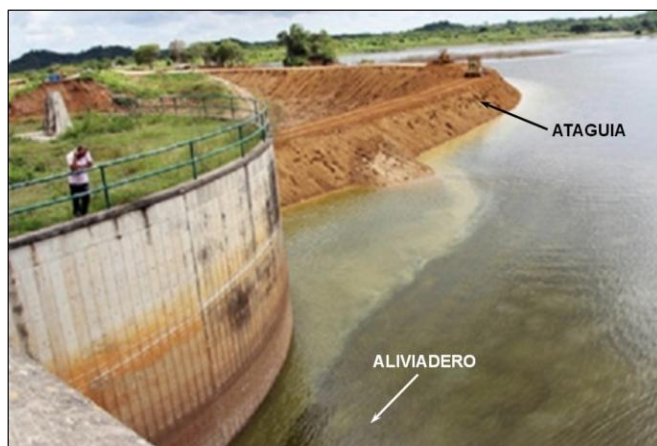
Figura 17: En Diciembre de 2012 Tuvo Lugar una Creciente Importante del Río Socuy, que Amenazó con Desbordar la Ataguía. (Cortesía de HIDROLAGO)
