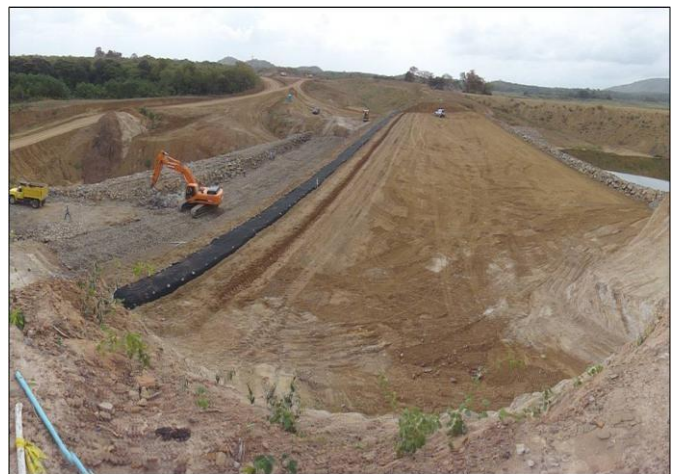
Figura 20: Construcción de las Distintas Zonas del Dique de Cierre
