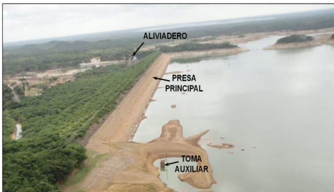
Figura 1: Vista General de las Obras de Embalse
