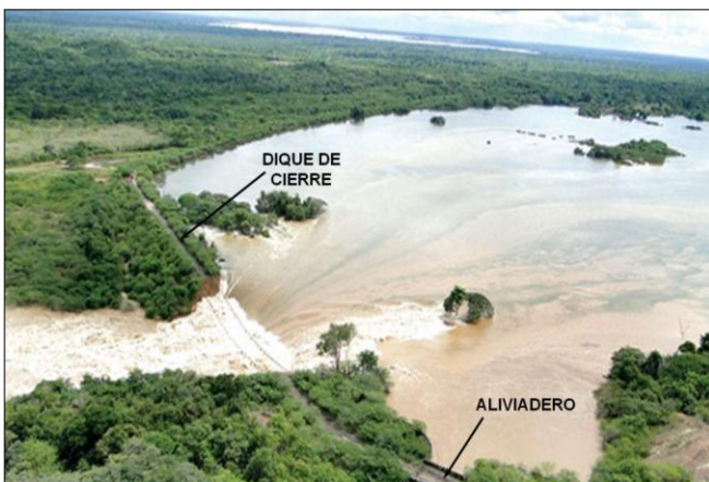
Figura 6: Rotura del Dique de Cierre Cerca del Aliviadero (05/12/2010). (Cortesía de HIDROLAGO – Pedro Montes)
