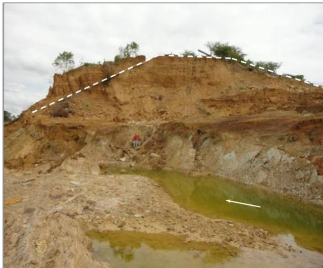
Figura 10: Sección Transversal del Dique, Expuesta en la Brecha Erosiva. Se Observa que es Homogénea, de Arcilla, sin Drenes Internos
