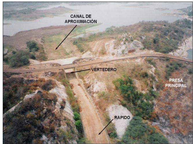
Figura 3: Vista del Aliviadero (04/1998)
