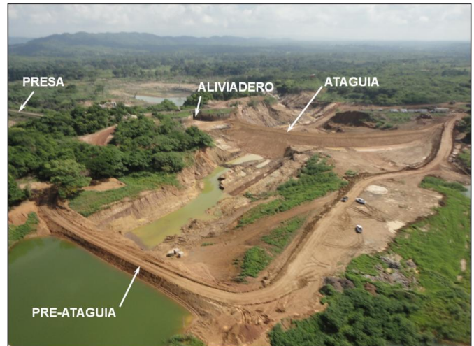
Figura 15: Atagüía Terminada
