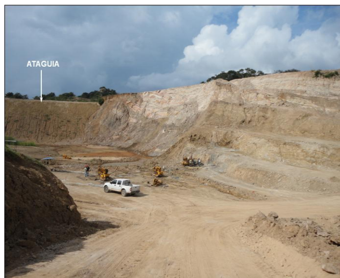
Figura 18: Excavación de la Fundación y Ejecución de la Cortina de Inyecciones de Cementación Para la Construcción del Tapón de Cierre
