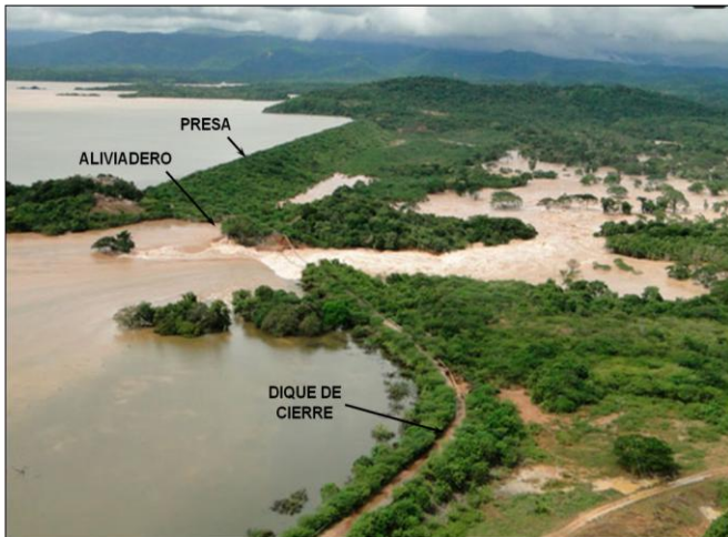
Figura 5: Rotura del Dique de Cierre Cerca del Aliviadero (05/12/2010). (Cortesía de HIDROLAGO – Pedro Montes)
