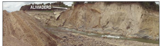
Figura 9: Detalle del Zanjón Erosivo Formado en el Sitio de la Rotura del Dique
