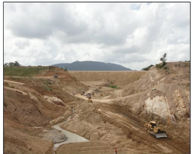
Figura 16: Vista Desde Aguas Abajo de la Atagüía Terminada. Excavaciones Para la Fundación del Dique de Cierre
