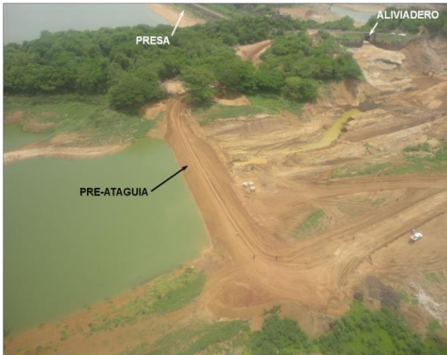
Figura 12: Pre-atagüía Terminada, Almacenando Agua en el Embalse
