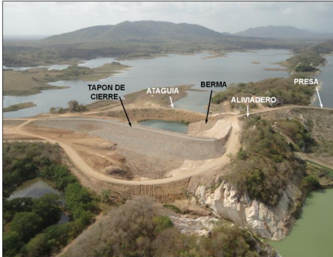
Figura 21: Dique de Cierre de la Brecha Terminado
