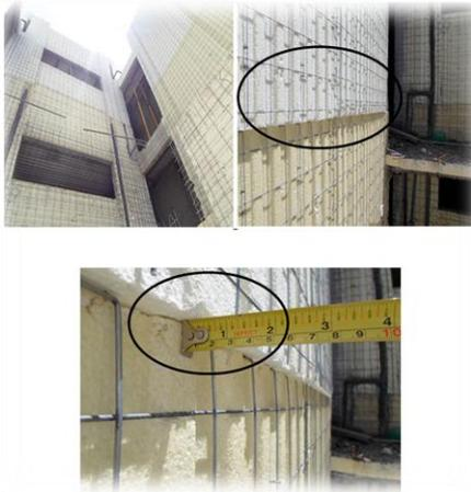
**Figura 3.** Paneles internos y externos mal colocados
