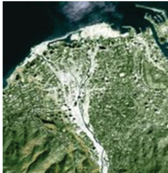
Figura N°5 Vista Aérea del deslave de Vargas (1999).
