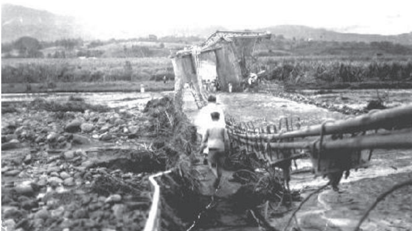
FIGURA 1.- Estado del Puente Libertador, luego que las Aguas Pasaron por Encima de la Plataforma Vial en 1943 (fuente: http://www.rescate.com/inundacion.html )
