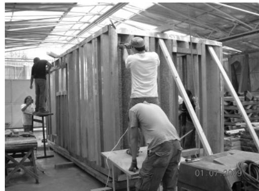
Fotos 18, 19, 20 y 21. Aplicación de revestimientos secos al prototipo Sipromat
