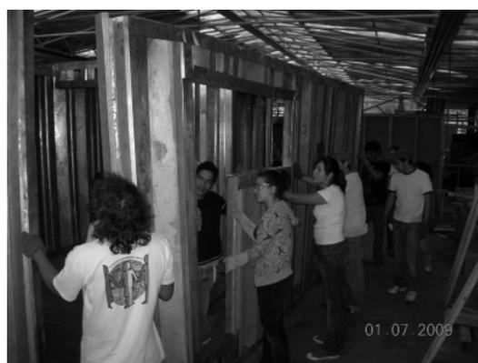
Fotos 14 y 15. Montaje de paredes portantes Sipromat
