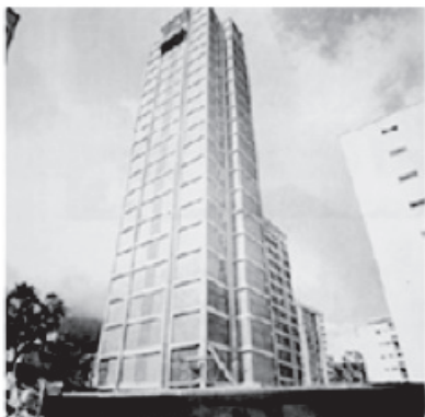
Edificio Petunia II (después del sismo de 29-07-67) Fachadas Oeste y Sur. Falla de la columna A-1 (10) .
