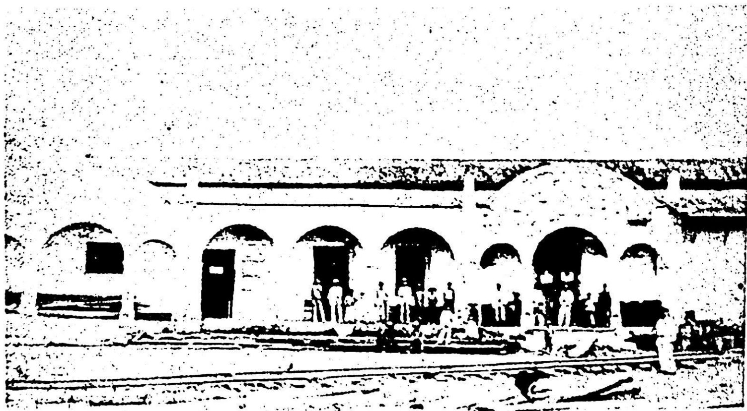
Fig. 4) Estación Encontrados, 1904. Fuente: VENEZUELA. MINISTERIO DE OBRAS PÚBLICAS. 1905. Memoria . Caracas, p. 172.
