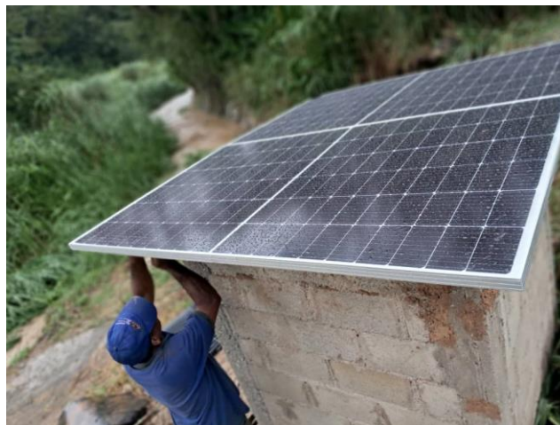
Figura 7: Instalación de los paneles solares
